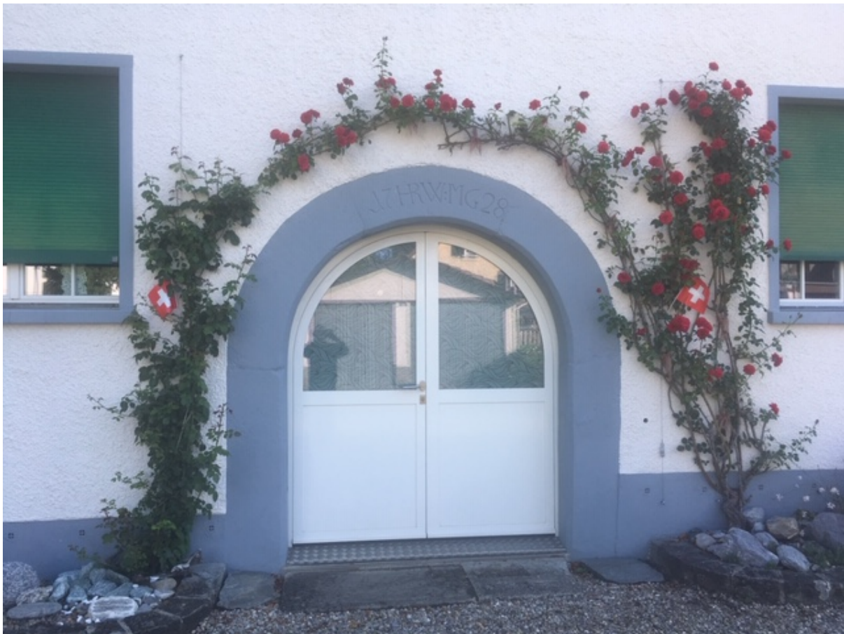
Abb.13.3. Ehemaliges Gerichtsgebäude: Erhalten gebliebener rundbogiger Kellereingang mit der Jahreszahl 1728
